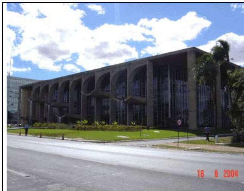
Edifício Sede do Ministério da Justiça – Brasília-DF.
